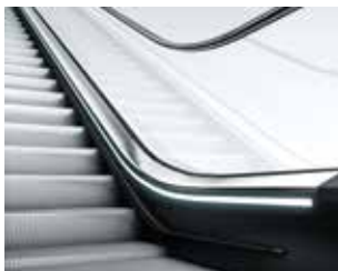
Iluminare plintă cu bandă luminoasă
